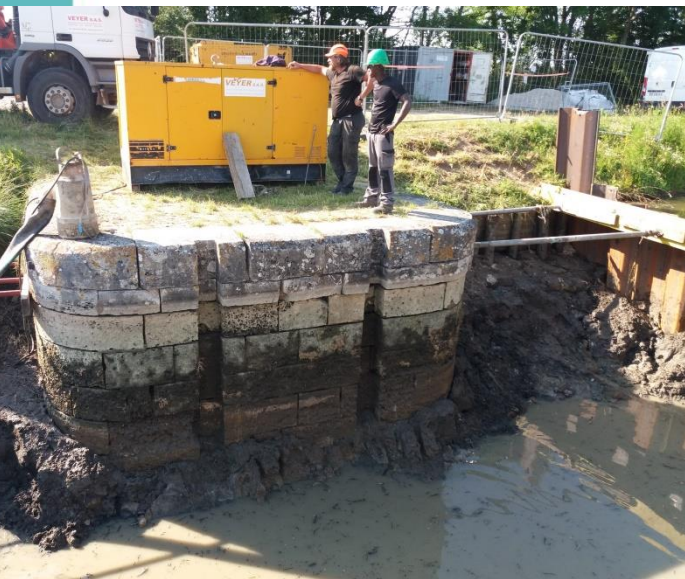
Pertuis des Coulisses –Sury aux Bois
