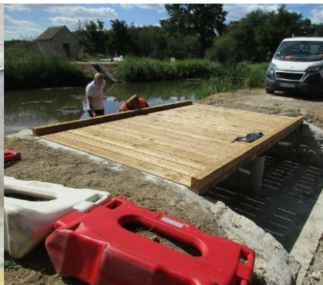
Déversoir de la Noue Mazone-Chatenoy
