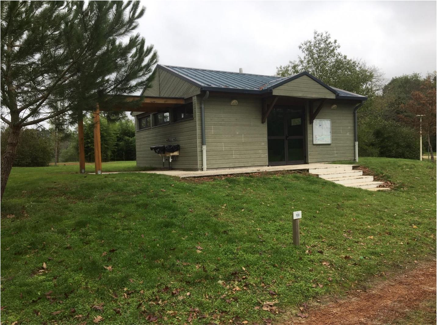
Les bâtiments sont en ossature et bardage bois avec isolation. Les sols sont en carrelage avec pente et caniveaux. Afin de faciliter l'entretien et l'hygiène en générale aucun appareil sanitaire ne repose au sol. L'ensemble des canalisations d'alimentation et d'évacuation sont apparents dans le couloir technique, afin d'éviter les dégradations et de faciliter l'entretien et le dépannage. Les vitrages sont tous du type retardateur d'effraction.
