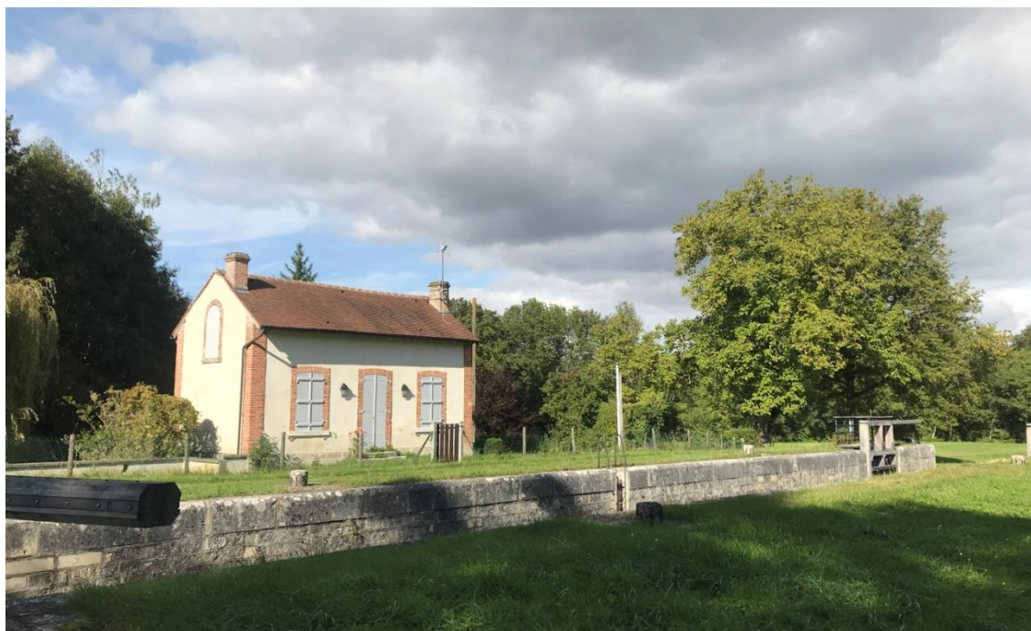
Figure 1 : Vue générale de la maison
