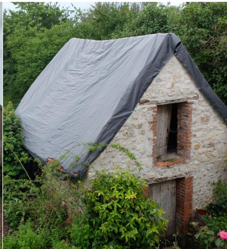
**Se préoccuper de la présence de l'eau** : la gestion des eaux de pluie, les eaux souterraines, l'humidité dans les maçonneries (humidité > 80 % : moisissures ; humidité > 93 % : activité bactérienne)
