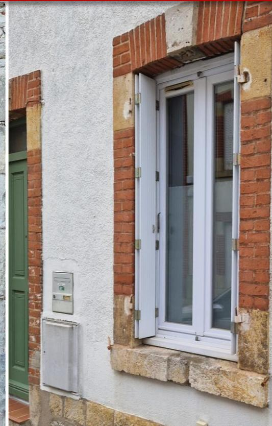
**Identifier les apports de réhabilitations non compatibles** avec les qualités architecturales et hydrométriques du bâti ancien : moellons de pierres apparentes non enduites, volets roulants, PVC, blanc pur, enduits hydrofuges (ciments, plastiques)
