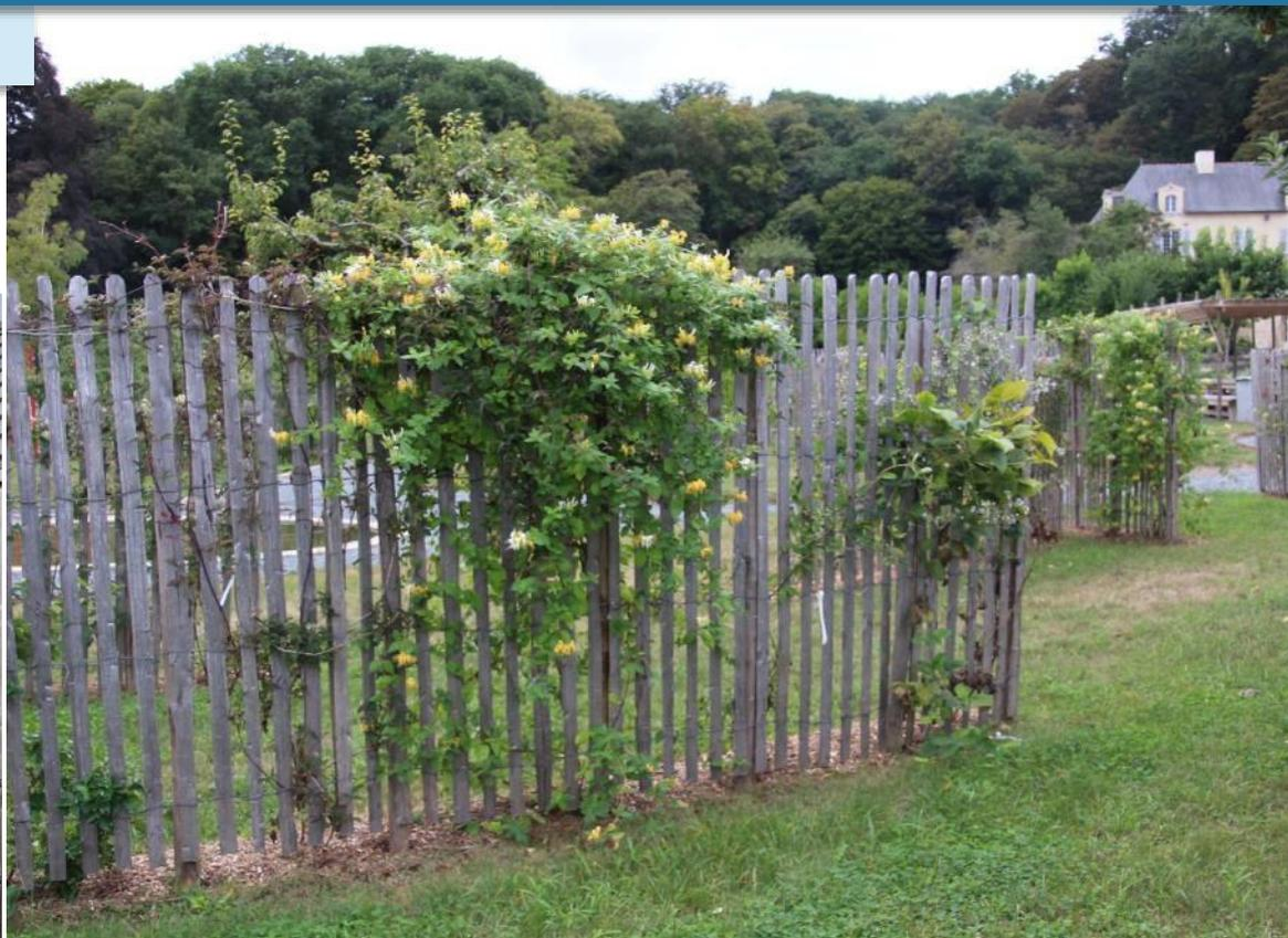
Ganivelles (lattes de bois assemblées par fils de fer galvanisé), clôture visuellement perméable.
