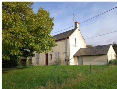
Maison éclusière de Pont-aux-moines
