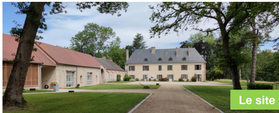
Les abords du site
